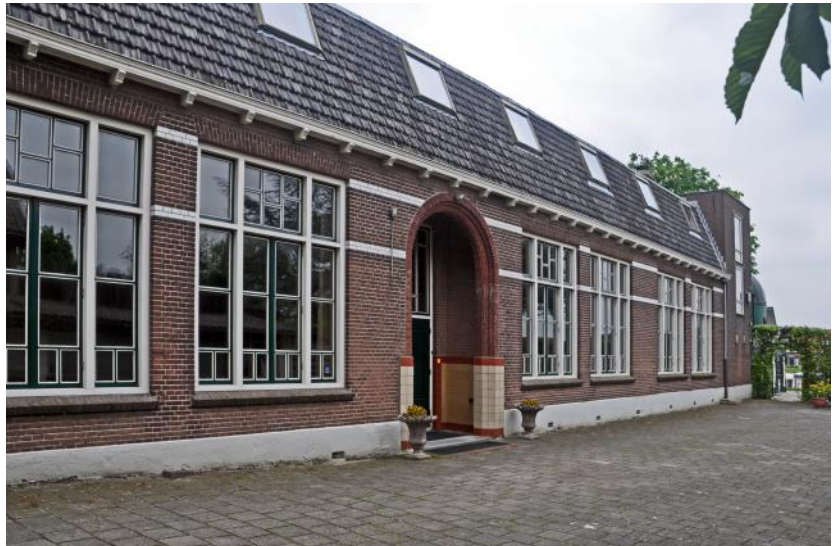
Voorgevel school. Bron: Stichting Oud Ridderkerk, nr. 1911.003.048
