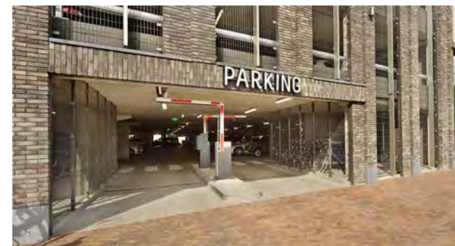
De inrit naar de parkeergarage past in het gevelbeeld (nr.6)
