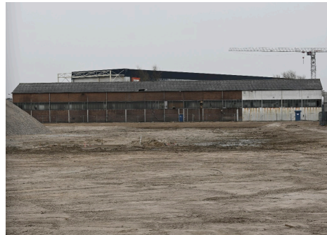
6. Westgevel: in wit gekeimd [niet oorspronkelijk] is een gedeelte van Y6.0A.
