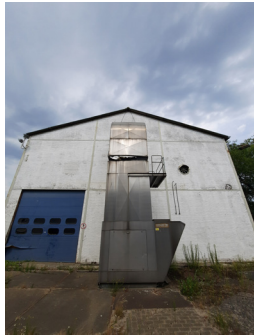
1. Zuidgevel: de openingen en installatie zijn later aangebracht.
