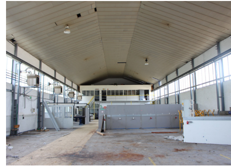
11. Interieur richting de zuidgevel. Tegen de muur in de loods werd in de jaren negentig een twee-laagse volume geplaatst.
