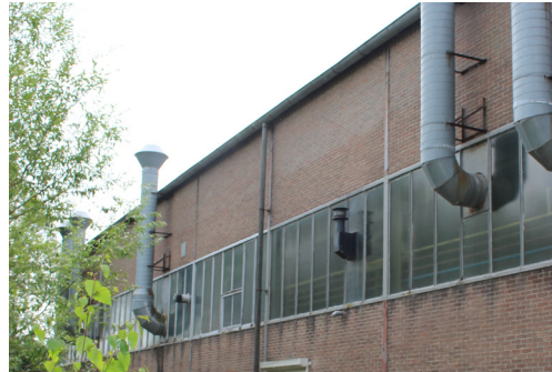
3. Schoorstenen van het ventilatiesysteem via de stalen vensters. Deze zijn niet oorspronkelijk, maar later aangebracht.
