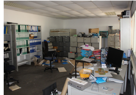
14. Kantoor op de verdieping. Hier werd een nieuw raam gemaakt voor meer daglicht.
