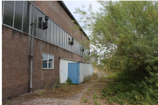
2. Oostgevel met kleine aanbouw van stalenplaatmateriaal [later aangebracht].
