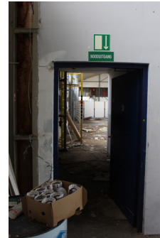
15. Gang tussen de twee gedeelten van de loods.
