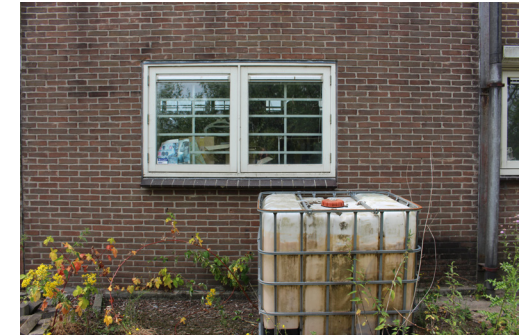
8. Later aangebrachte ramen in de oostgevel, voor de kantoren op de begane grond.
