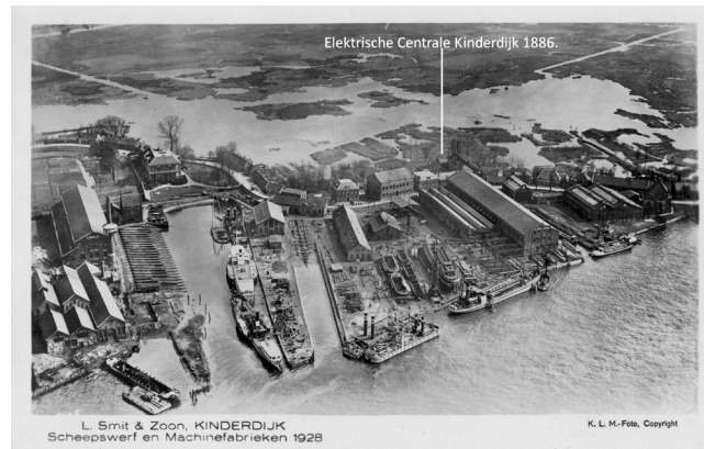
Elektrische centrale in Kinderdijk.
