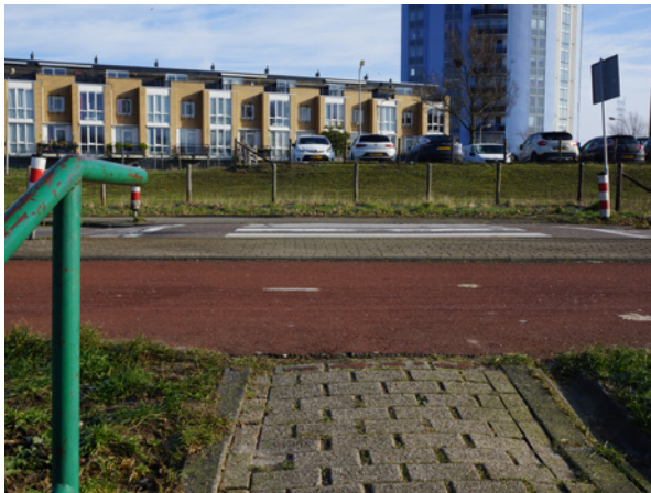
Overgang over de dijk in Bolnes: onduidelijke oriëntatie
