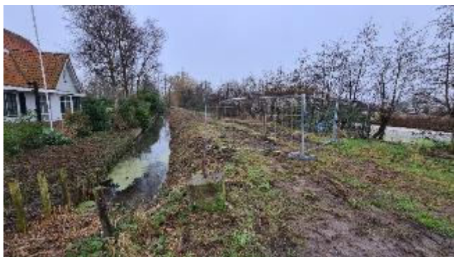
Figuur 2.1 Huidige situatie ter plaatse van de te realiseren inrit aan de Waalweg
