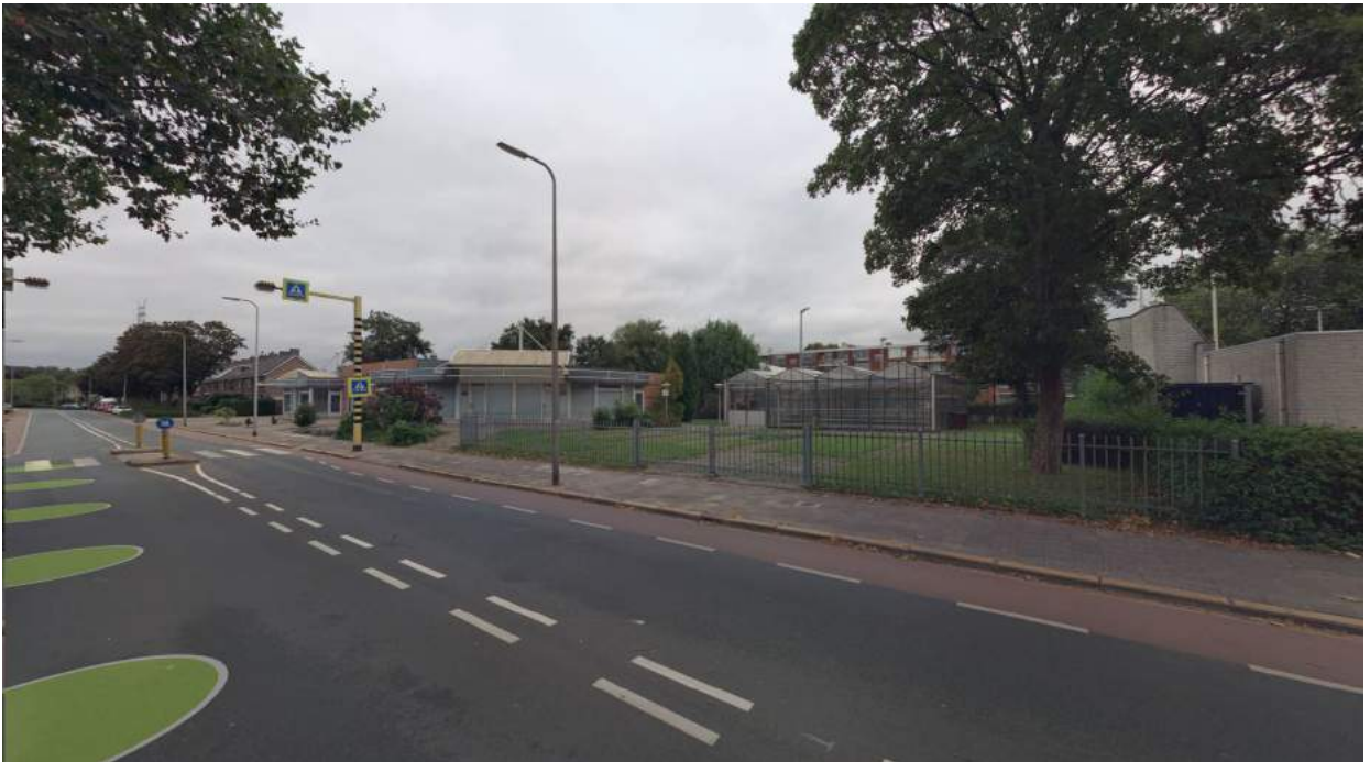
Figuur 2.2: Plangebied gezien vanaf het zuidoosten, met de naastgelegen Moskee op de voorgrond (bron: Cyclomedia streetsmart 2023)
