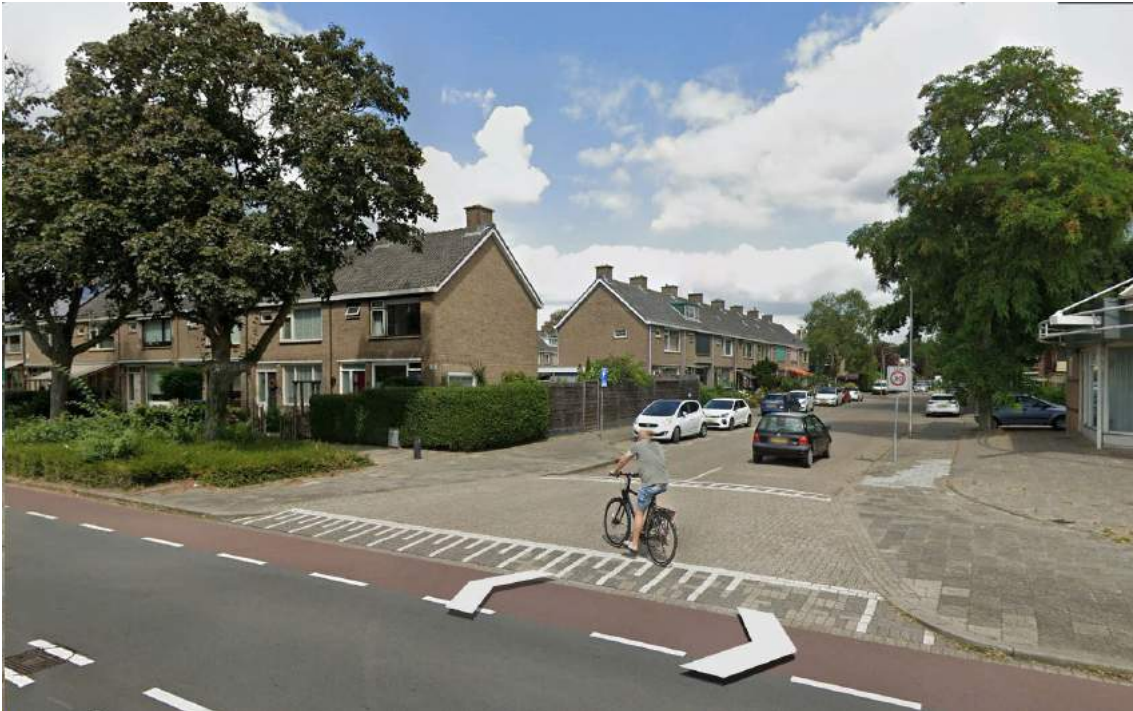
Figuur 2.6: Bestaande laagbouw op hoek Bachstraat/Bizetstraat (bron: Google Streetview augustus 2022).
