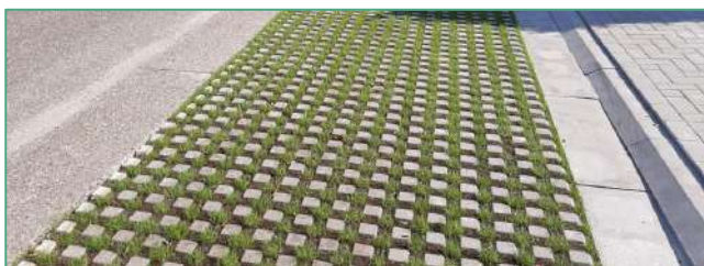
Afbeelding 4.2 voorbeeld waterdoorlatende verharding
