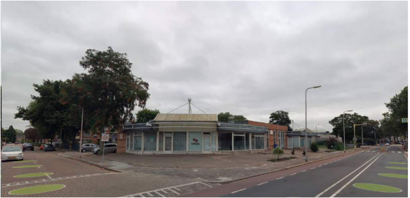
Figuur 2.3: Plangebied gezien vanaf het zuidwesten (bron: Cyclomedia streetsmart 2023)
