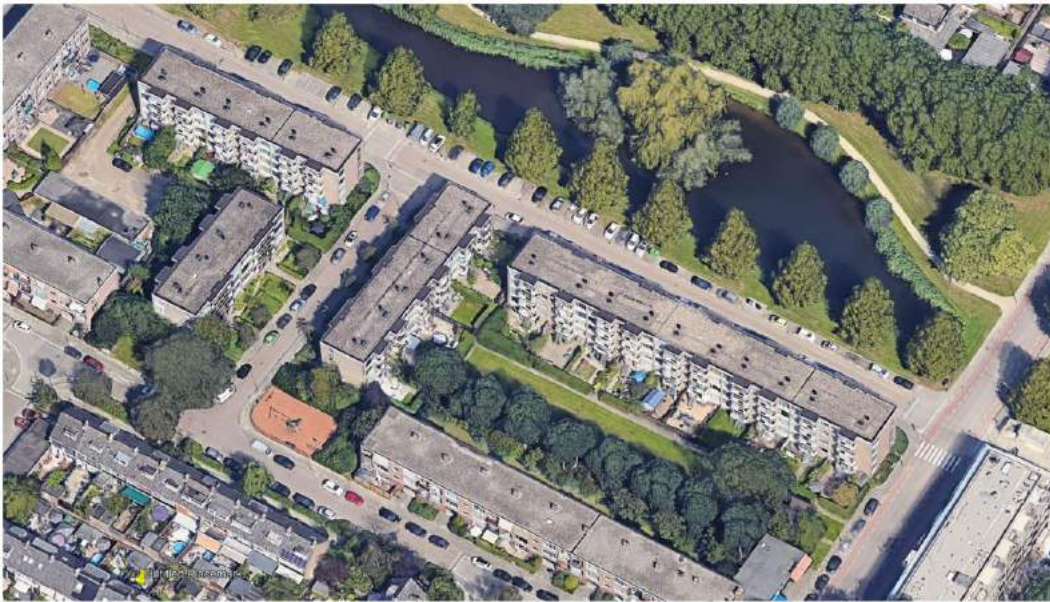
Situatie | Bestaand, sloop van 94 portiek woningen
