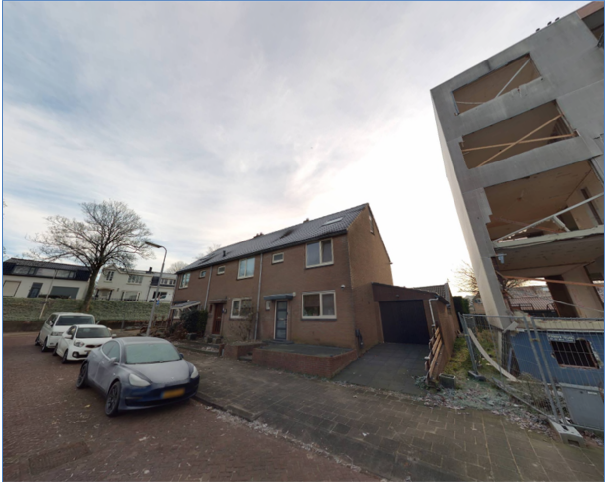
Figuur: Naastgelegen rijwoningen en te slopen appartementencomplex.
