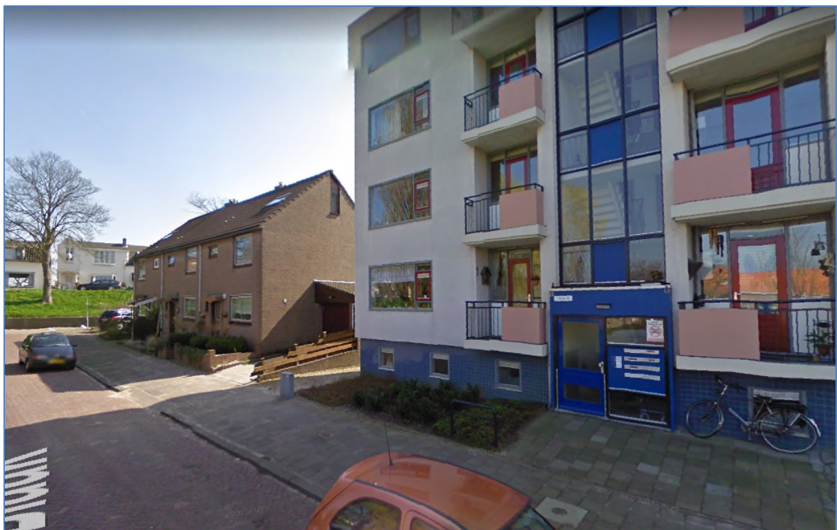
Figuur: Naastgelegen rijwoningen en te slopen appartementencomplex.
