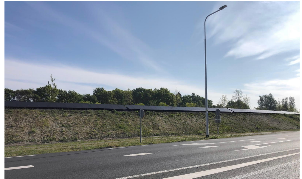
Voorbeeld zonnepanelen op geluidwal (locatie: N303 Voorthuizen)
