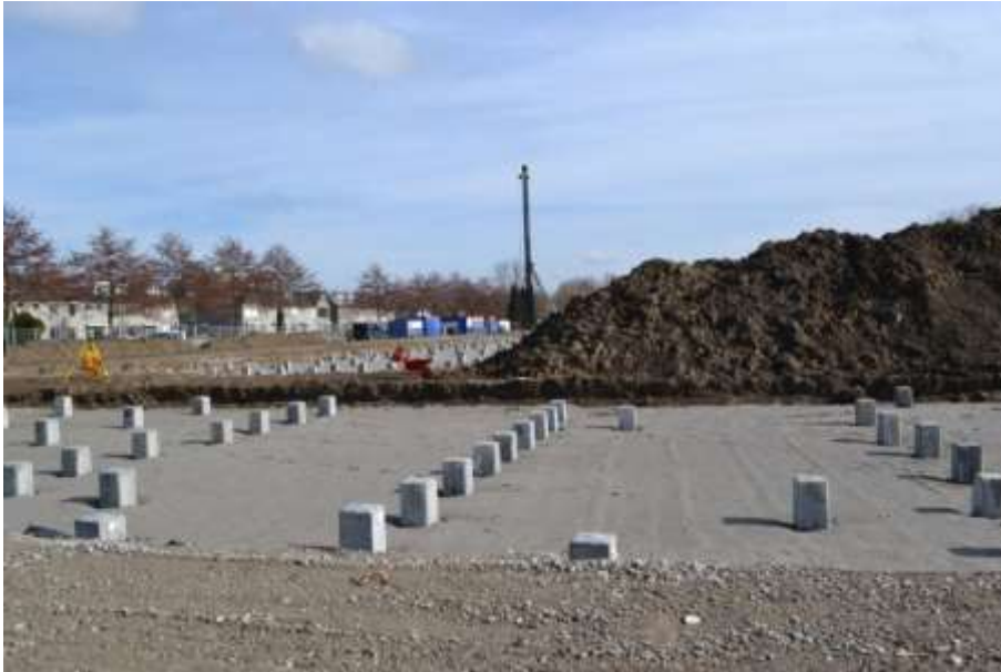
Grondverkoop fase 4 Het Zand 2017; start bouw februari 2018 (maart 2018)
