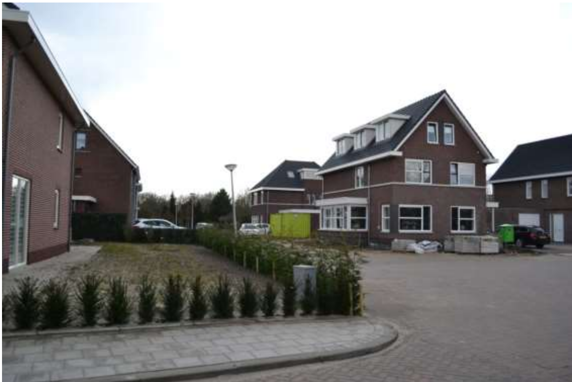
Woningen in aanbouw aan de Lagendijk (maart 2018)
