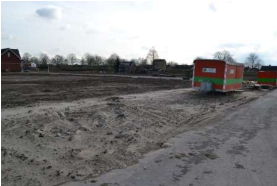
Fase 5 Het Zand bouwrijp gemaakt (maart 2018)
