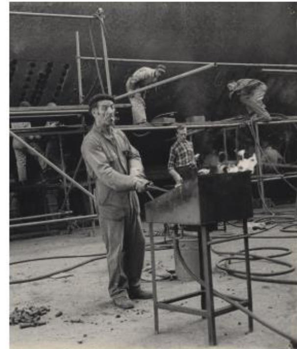
Werkzaamheden op de Boele werf (bron: Stichting Oud Ridderkerk)
