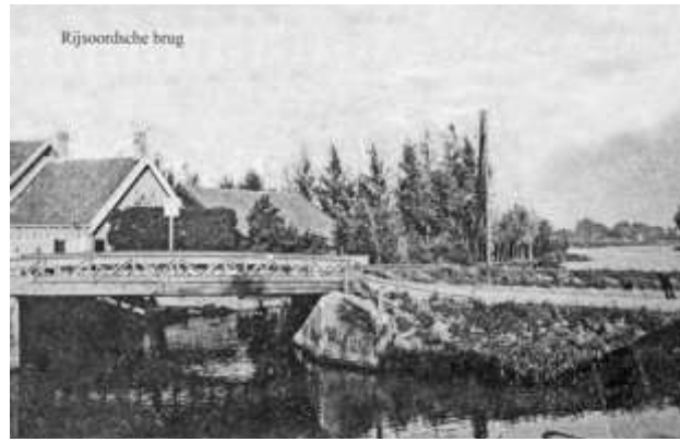
De Rijsoordse brug.
