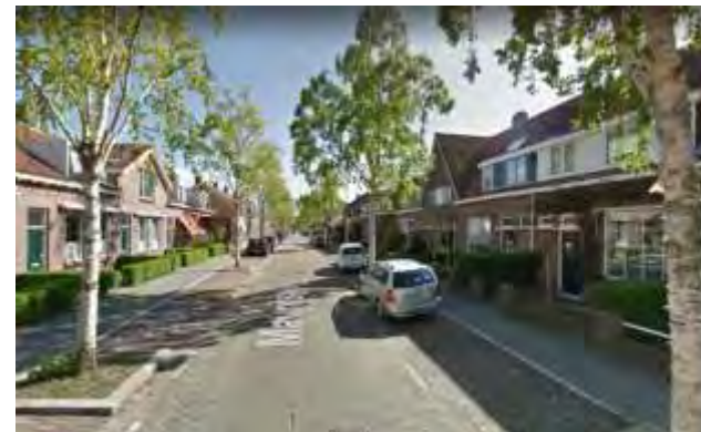
Arbeiderswoningen met lage gemetselde tuinmuren en hagen uit het begin van de 20 ste eeuw van Patrimoniums Woningstichting.
