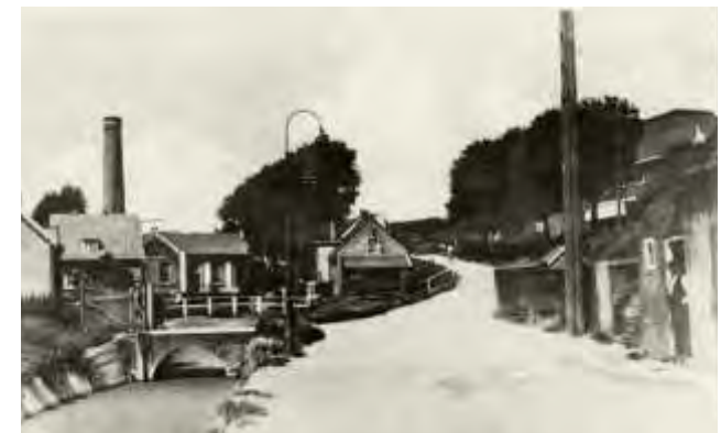
Het stoomgemaal Dick Maaskant uit 1880 met schoorsteen aan de voet van de Ringdijk verving de molenviergang en uitwateringssluis.
