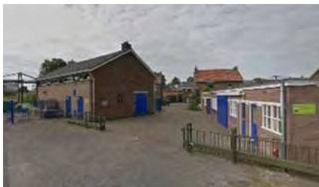
Gemaal Oud- en Nieuw-Reijerwaard en werkplaats (Bothastraat 9 en 13).
