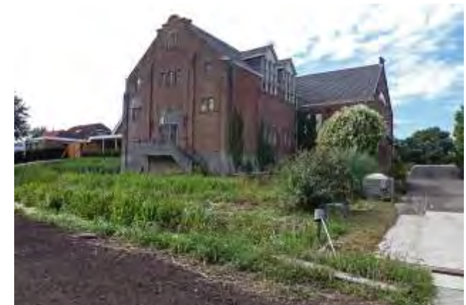
Achterzijde van De Gereformeerde Gemeente Kerk
