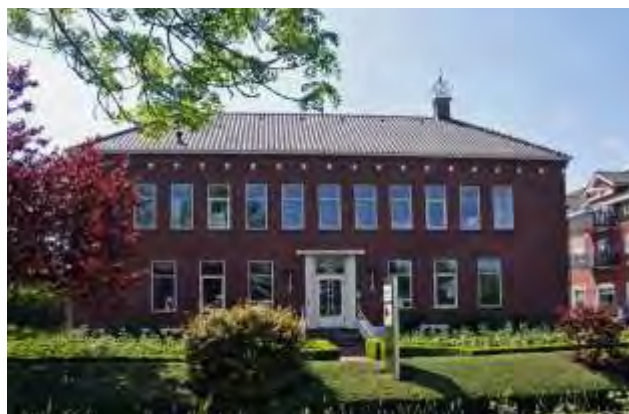
Het voormalige hoofdkantoor en bedrijfscomplex van Vlasserij Van Nes (nr. 33, bj. 1957). Het achterliggende terrein is ontwikkeld tot woongebied.
