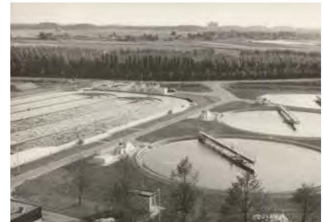
Rioolwaterzuivering in de Gorzen.
