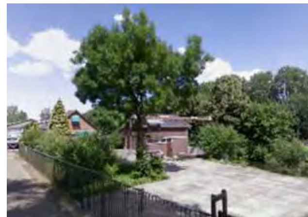
Gemaal Dijkje uit 1960 (ondergemaal Dijkje 163b).
