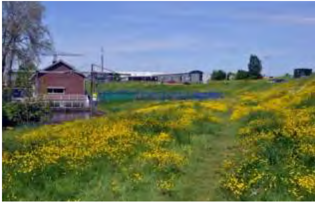
Het elektrische Gemaal Oud- en Nieuw-Reijerwaard uit 1964 verving het oude stoomgemaal Dick Maaskant uit 1880.
