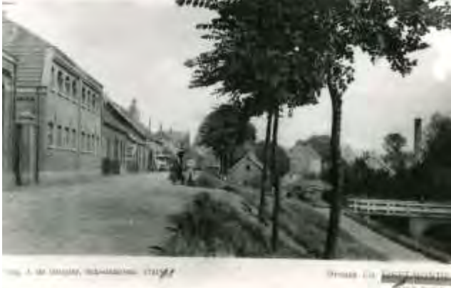
De Ringdijk in Bolnes met links de gebouwen van Scheepsbouwer Boele, rechts de hoge boezem en de schoorsteen van het stoomge- maal
