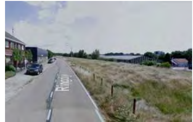
Ringdijk t.h.v. woningen nr. 534 en 536. Onderaan de dijk uiterst rechts de witte historische boerderij uit 1900 aan het Laantje 2 (volgens BAG sloopvergunning).
