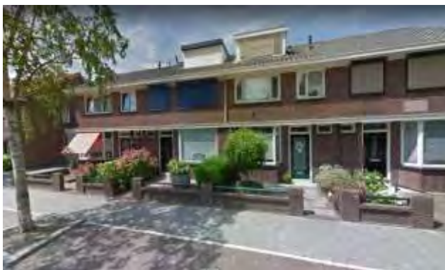
Tweelaagse woningen met lage gemetselde tuinmuren en hagen uit de jaren 30 van de 20 ste eeuw.
