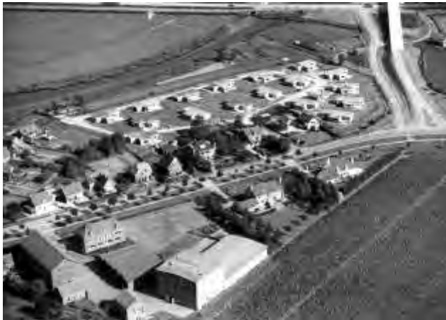
De zelfbouw bungalows van 'Thomsensoord' in aanbouw.
