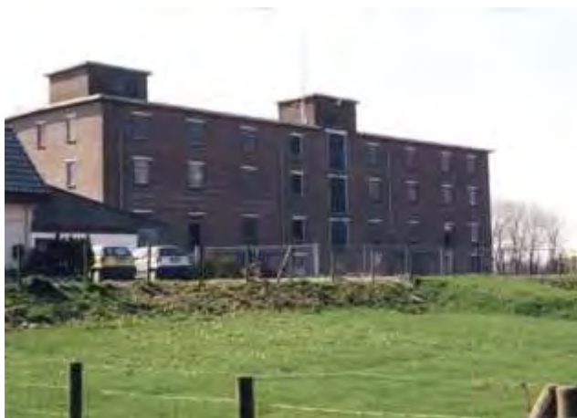
De voormalige vlasfabriek van Van Nes aan de Waaldijk.
