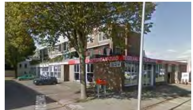
Karakteristiek bedrijfsverzamelcomplex met bovenwoningen Zinkstraat 5 (bj 1970).
