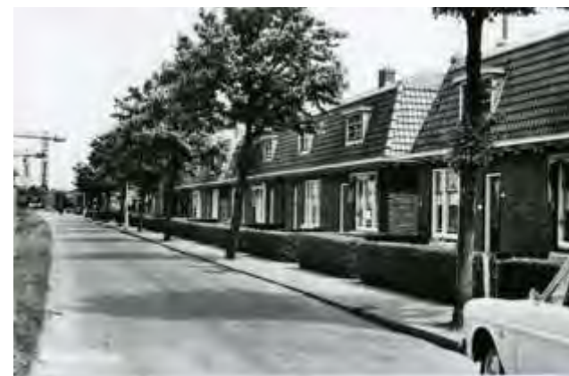
Dijkje met sloot langs de woningen gedempt.
