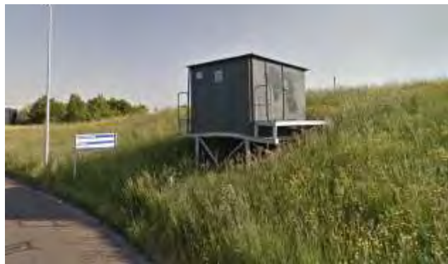
Hevel of vacuümpomp bij. 1970 op dijktaalud t.h.v. Gemaal Oud- en Nieuw-Reijerwaard (t.h.v. Ankerplaats 1-16).
