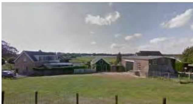
Het gemaal bj. 1935 (nr. 58) ter vervanging van de watermolen met links van het gemaal de dubbele arbeiderswoning uit 1925 (nr. 60-62).
