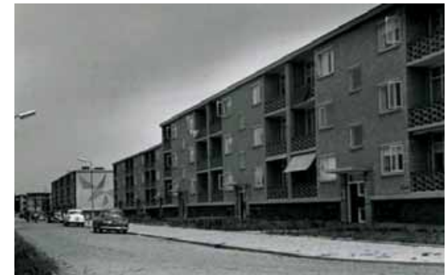
Straatbeeld Mr. Kesperweg ca. 1970 van het wederopbouw ensemble met betonnen honingraatstructuren
