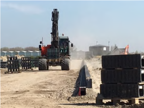
Foto: aanleg Selderijweg
